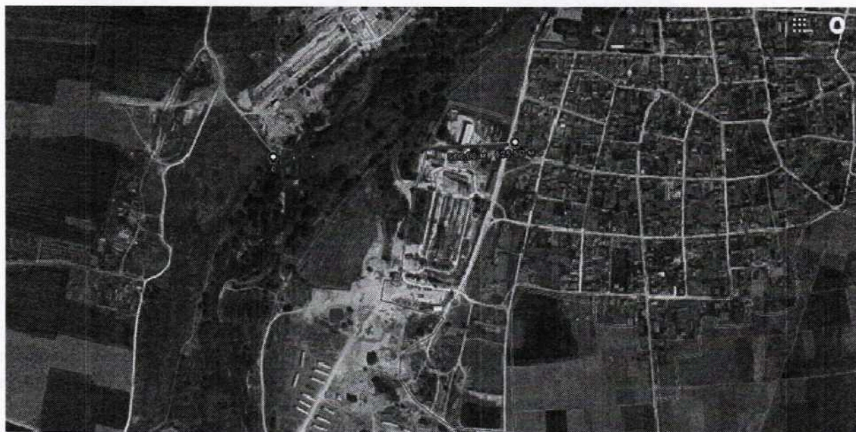
Местоположение на ИП и отстояние до най-близкото населено място – с. Катуница
