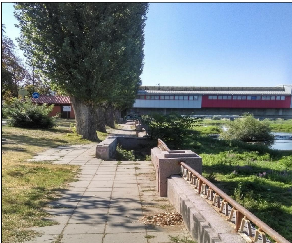
Фигура 34: Съществуващо състояние на моста на ул. „Брезовска“, гр. Пловдив и прилежащите му пространства /08.09.2017 г./
