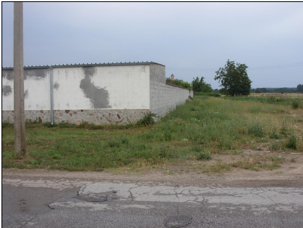
Снимка 6. Съществуваща земеделска кооперация в предвидената устройствена зона Пп (в северозападна посока) в с. Неделево, разположена в близост до границата на ЗЗ ВГ 0000444 „Река Пясъчник“
