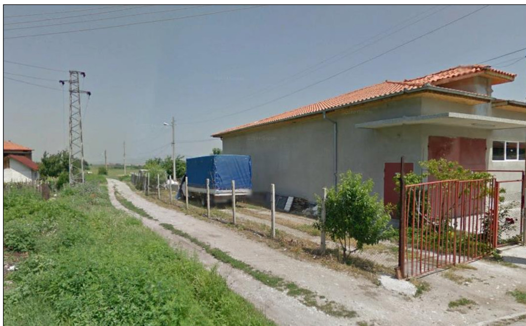
Фиг. 40 Съществуващи постройки в ПИ № 39921.9.62, земл. гр. Крчим в УЗ Пск, в която попадат части от потенциално най-благоприятните на вида Rhinolophus hipposideros
